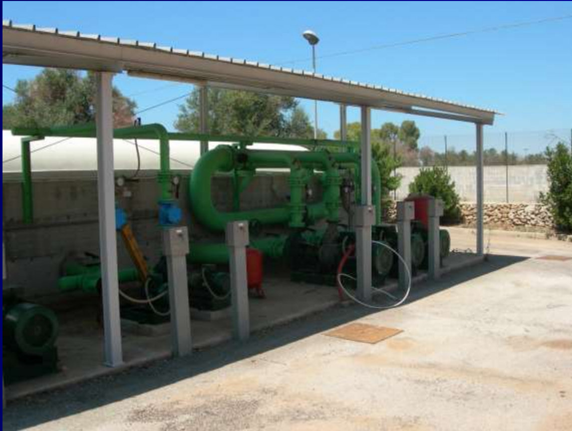
Fig. 5: Stazione pompaggio alla rete di distribuzione
