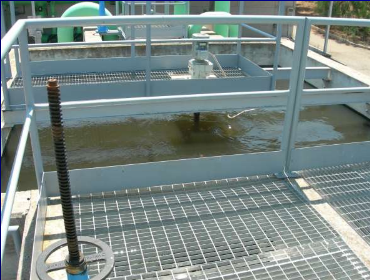
Fig. 2: Stazione di miscelazione-flocculazione
